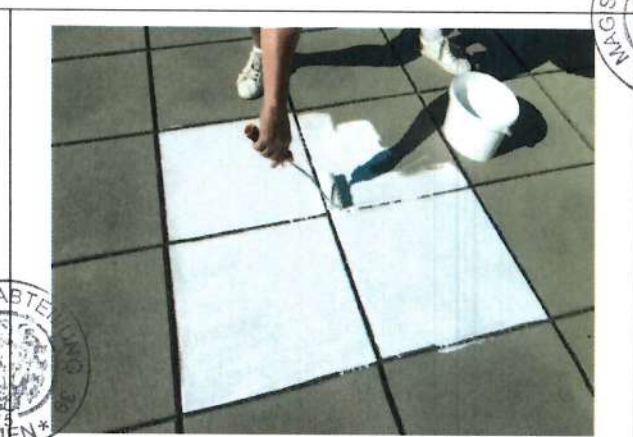
Bild 2 (IMG 1401): Aufrollen der Beschichtung Image 2 (IMG 1401): Roll up of coating
